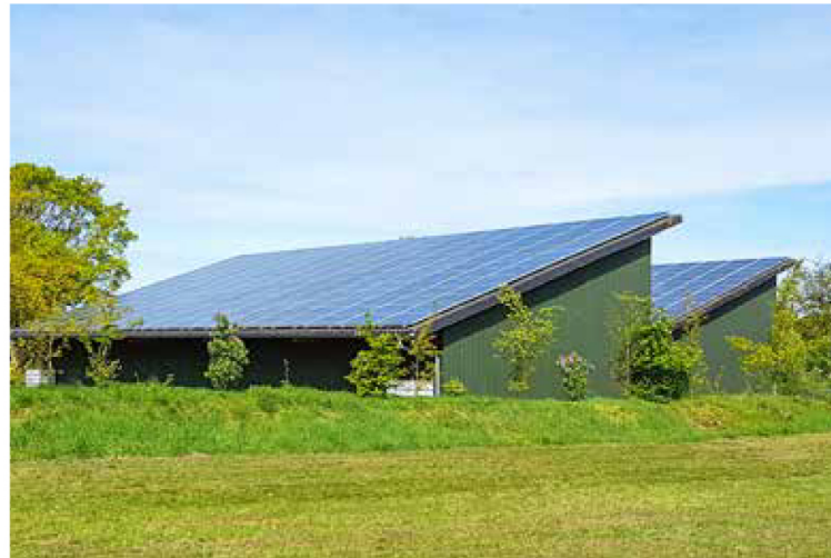
Auf vielen landwirtschaftlichen Hallen wird die Photovoltaik für die Energiegewinnung eingesetzt. Fotos (2): pm hallenbau & photovoltaik
